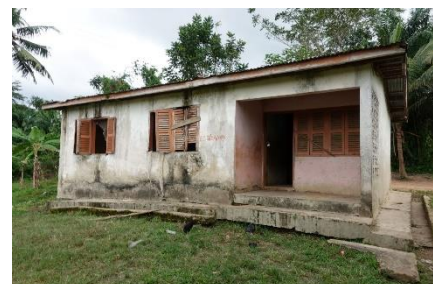
老朽化して使用されていない現在の教員宿舎
